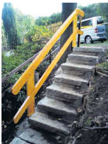
Bau der Zugangstreppe am Gutsfriedhof
